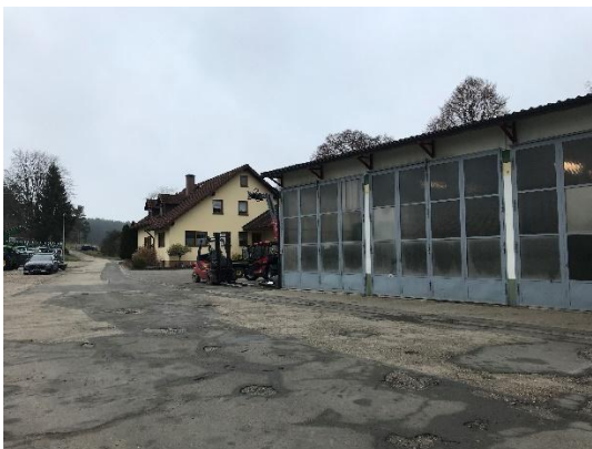
Abb. 6: Bebauung im Nordosten (Flur-Nr. 557, 557/3), Landmaschinenhändler und Wohnhaus
