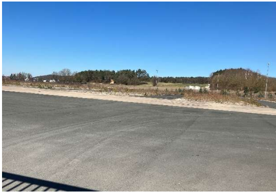
Abb. 3: versiegelte Kranflächen mit beginnender Verbuschung in den wasserdurchlässigen Bereichen (BC, 18.03.2025)
