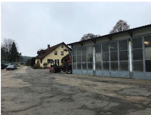
Abb. 6: Bebauung im Nordosten (Flur-Nr. 557, 557/3), Landmaschinenhändler und Wohnhaus
