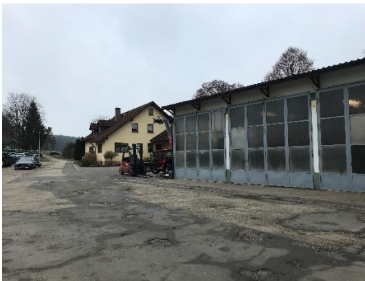
Abb. 5: Bebauung im Nordosten (Flur-Nr. 557, 557/3), Landmaschinenhändler und Wohnhaus
